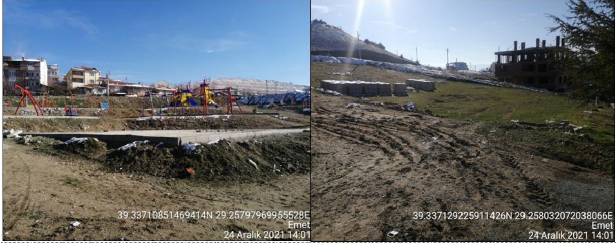
Şekil IV.2 Akpınar Mahallesi Anaokulu Proje Alanı Fotoğrafları
